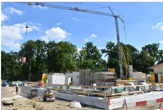
Neubau Bürogebäude der SUISAG, Stand 27.05.20
