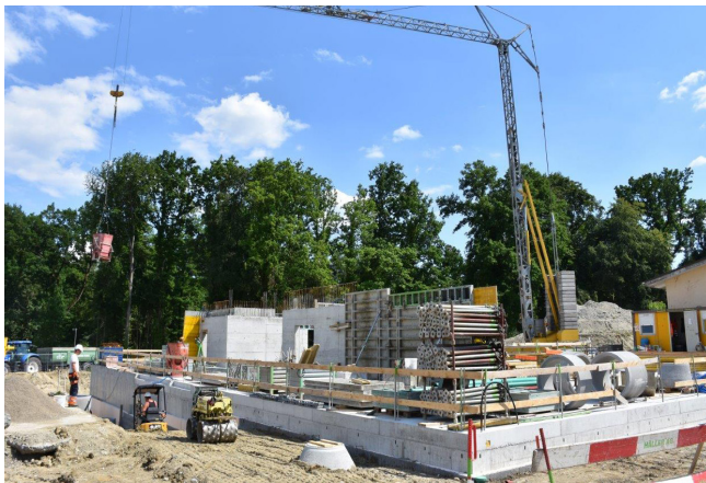
Construction du nouveau bâtiment de bureaux de SUISAG, avancement des travaux au 27.05.20
